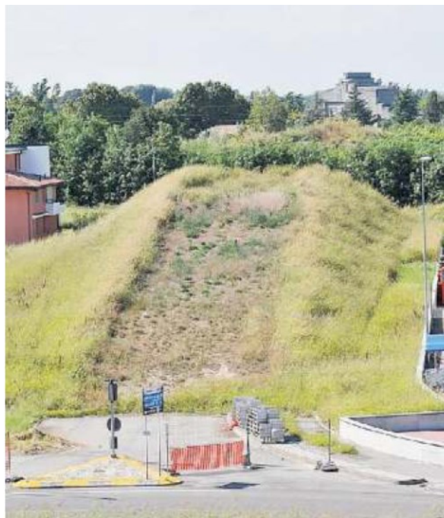
La rampa del cavalcaferrovia lato Sabbionetana, al rondò delle Torrette
