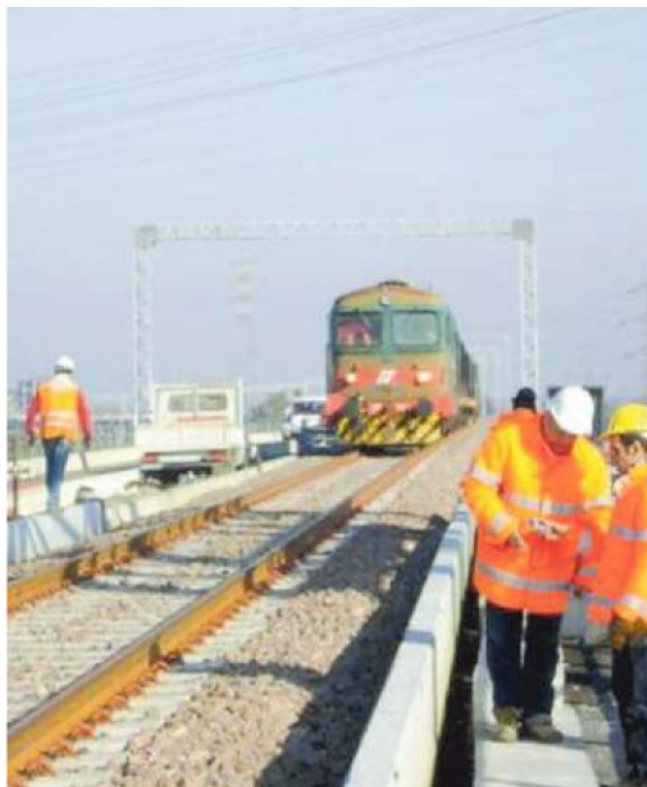
Il cantiere del raddoppio ferroviario durerà quattro anni FOTODIARCHIVIO
